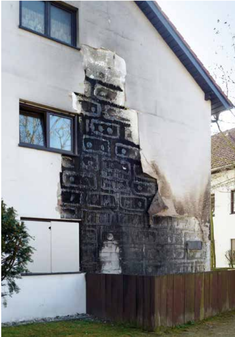
Typischer Schaden an einem Wärmeverbundsystem nach dem Brand von Mülltonnen
