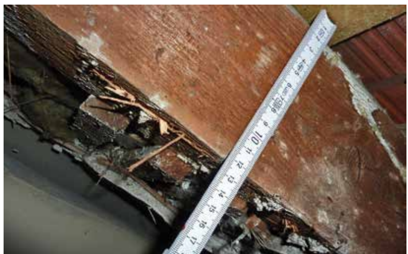
Decken- und Dachöffnung im Zuge der Bestands- aufnahme.
