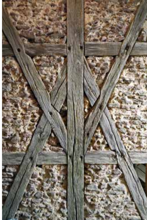
Fachwerk mit Bruchsteinmauerung der Gefache
