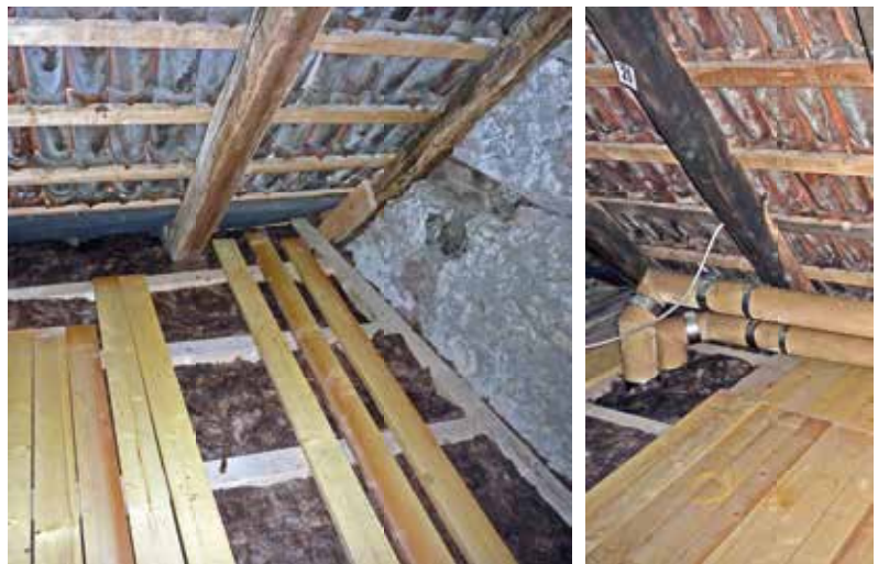
Dämmung der obersten Geschossdecke zwischen den Hölzern der Aufdoppelung der Balkenlage.
