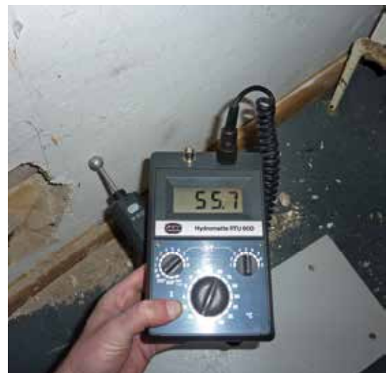
Feuchtemessung bei einem Mauerwerk
