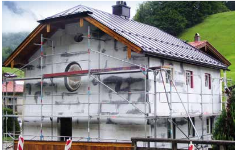
Außendämmung bei Baudenkmalern – keine Standardlösung
