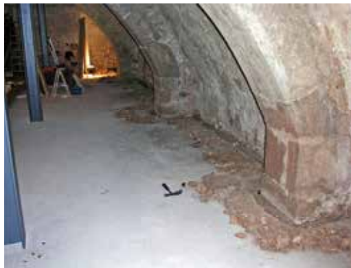
Temperierung im Sockelbereich eines Kellergewölbes
