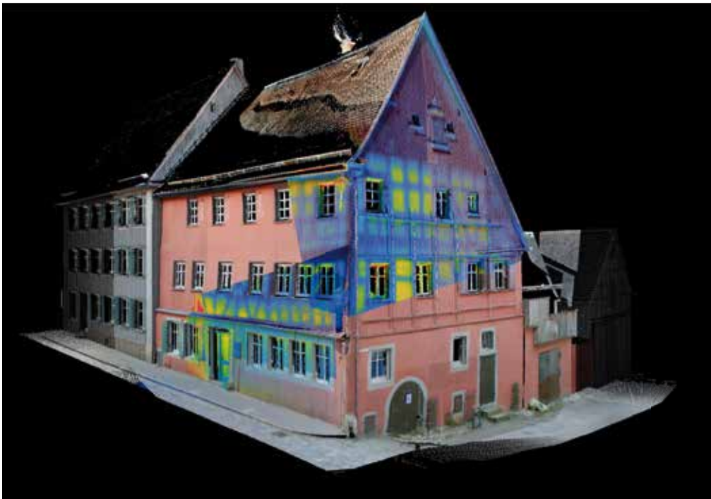
Wärmebildaufnahme eines historischen Gebäudes. Das verputzte Fachwerk des Obergeschosses zeichnet sich deutlich gegenüber dem massiven Erdgeschoss ab.
