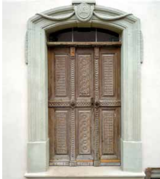
Links: Historisches Fenster mit Einfachverglasung das durch den Umbau zum Kastenfenster energetisch verbessert wurde. Rechts: Historische Eingangstür mit Oberlicht.
