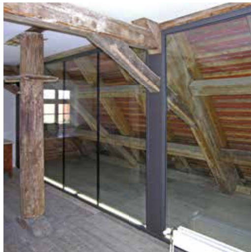
Ausbau eines Dachgeschosses im System »Haus im Haus«. Eine Verglasung der vertikalen Achse unter den Pfetten ermöglicht den Blick in den Dachraum auf das historische Dachwerk.
