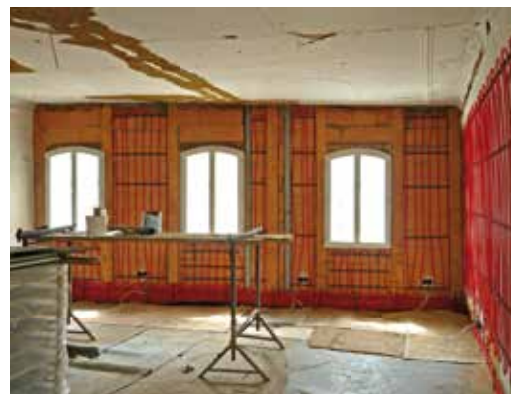
Links: Sockelleistenheizung als Komplettsystem Rechts:Wandheizung bei der Montage
