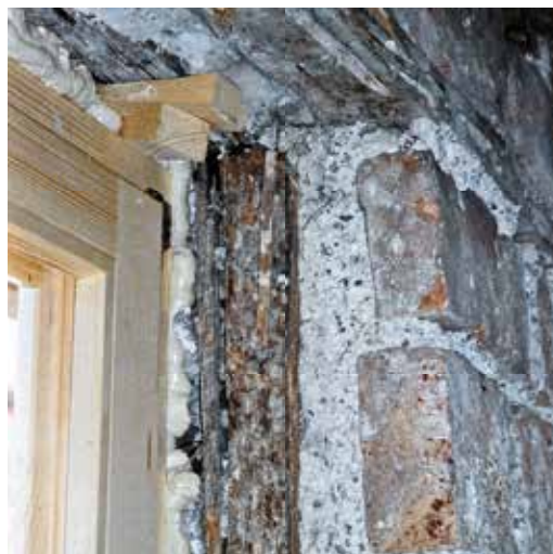
Historische Vormauerung auf der Innenseite
