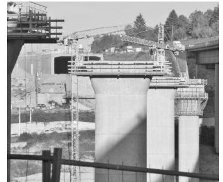
Blick nach Osten, hinten ist der Katzenbergtunnel zu sehen. Foto: Rehbein
